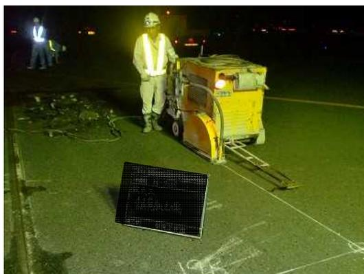
写真 5.1.4 舗装版切断状況
