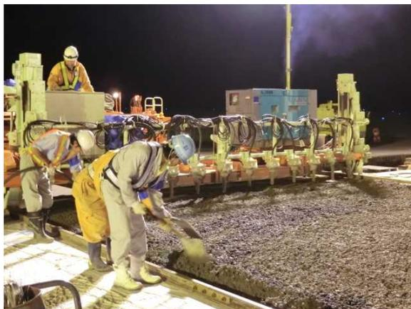
写真 5. 2. 23 内部振動締め固め機による締め固め状況
