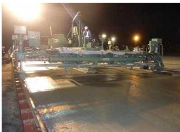
写真 5. 2. 25 縦型表面仕上げ機による平坦仕上げ状況
