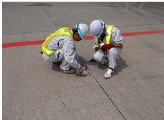
写真 5. 2. 1 ひび割れ充填材の注入状況
