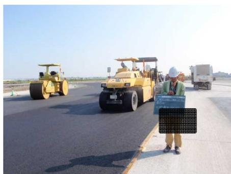
写真 5.2.8 アスファルト舗装転圧状況
