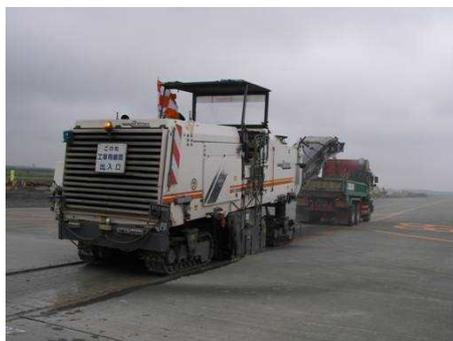
写真 5.2.9 既設コンクリート版の切削状況
