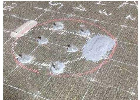
写真 5.2.5 台座取付け状況
