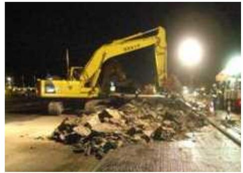
写真 5.2.17 既設コンクリート版撤去状況
