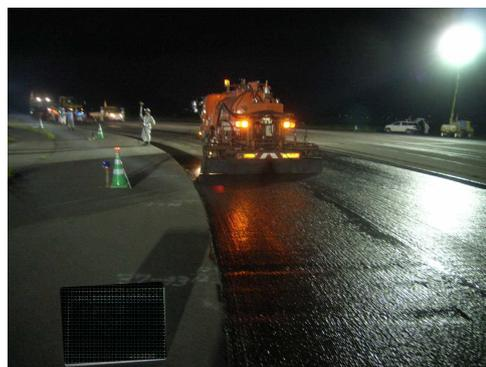
写真 5.1.17 As乳剤散布施工状況
