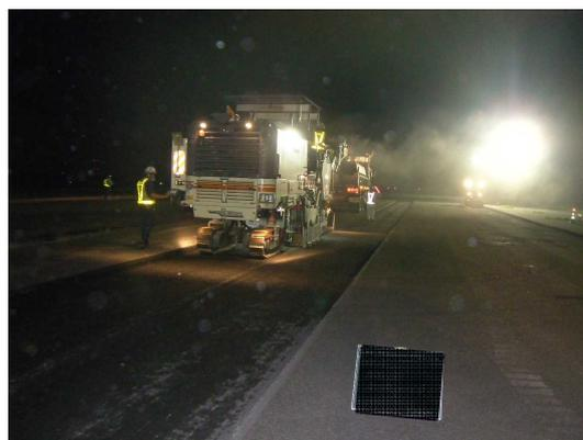
写真 5.1.16 切削施工状況
