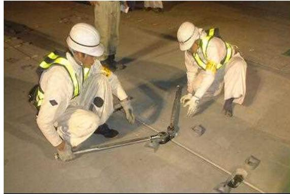
写真 5.2.34 コッター式継手の本締付け状況
