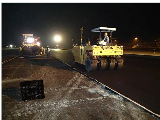
写真 5. 2. 18 上層路盤(アス安)転圧状況
