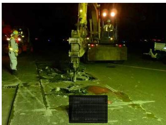
写真 5.1.5 舗装版撤去状況
