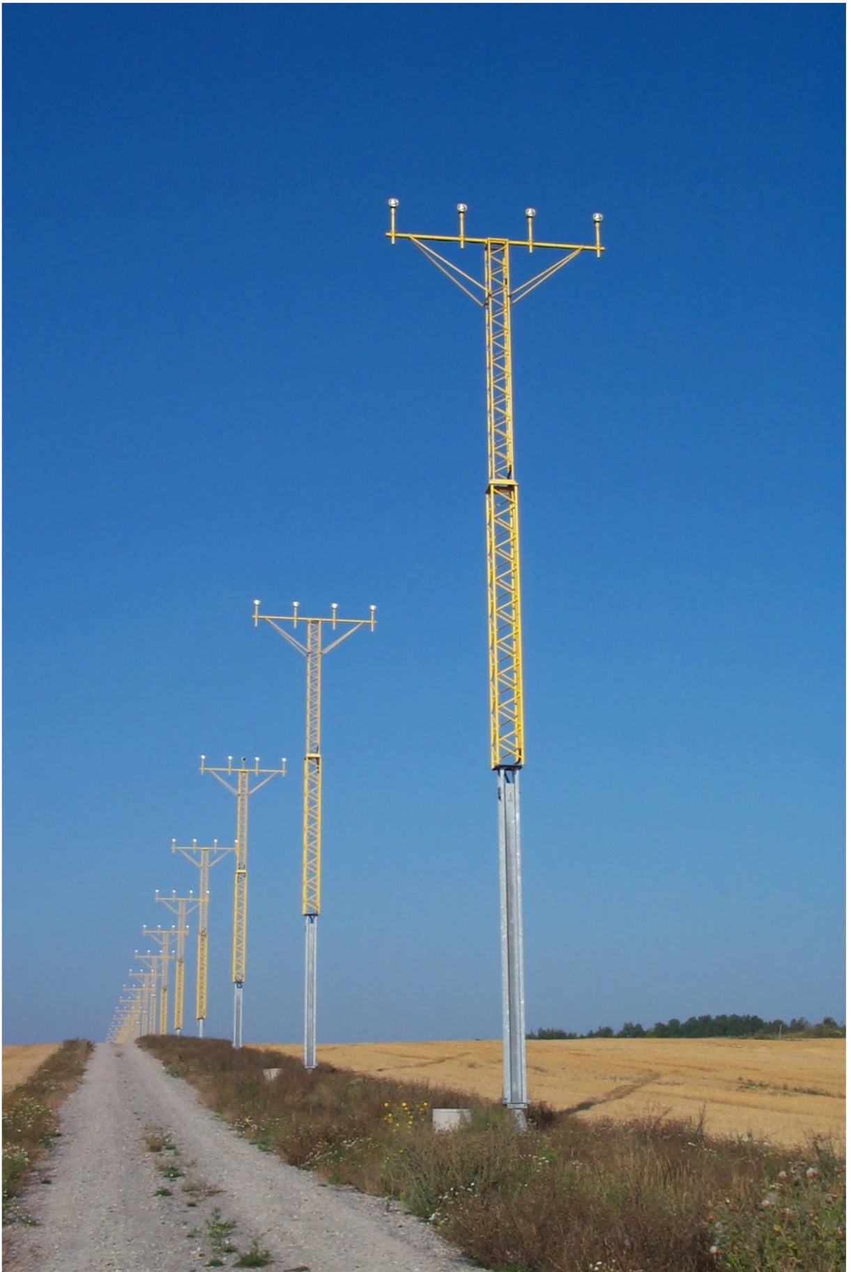
Hình 4-8. Cột đèn tiếp cận làm bằng sợi thủy tinh lắp trên các trụ cứng
