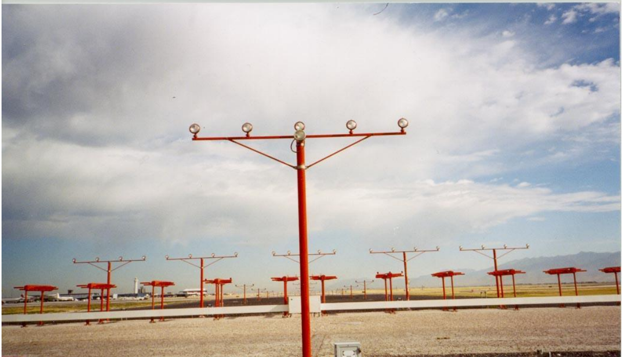
Hình 4-3. Cột đèn tiếp cận - cột hình ống bằng sợi thủy tinh
