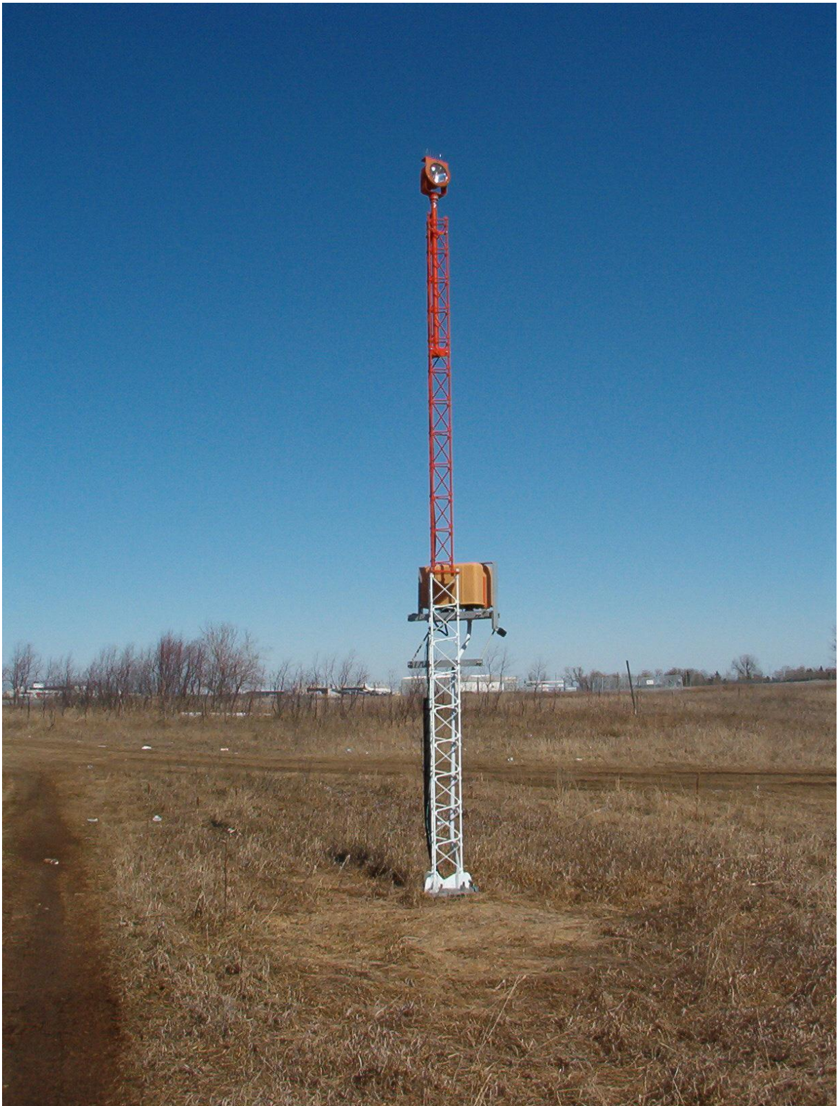
Hình 4-5. Cận cảnh cột đèn tiếp cận — cấu trúc nhôm
