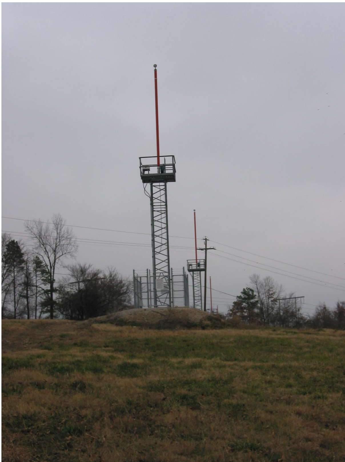
Hình 4-7. Cột ống làm bằng sợi thủy tinh lắp trên cấu trúc cứng
