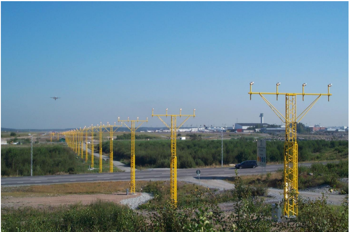
Hình 4-2. Cột đèn tiếp cận - cấu trúc sợi thủy tinh
