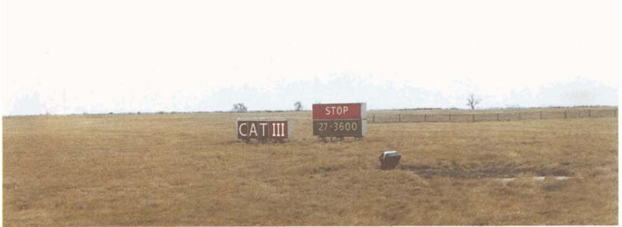
Hình A-4. Biển báo vị trí chờ đường lãn phương thức CAT III được lắp bên cạnh biển báo dừng
