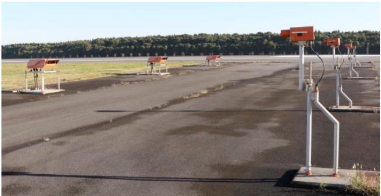
Hình 8-23. Lắp đặt cảm biến tự động giám sát (Nguồn: Sân bay quốc tế Narita)
