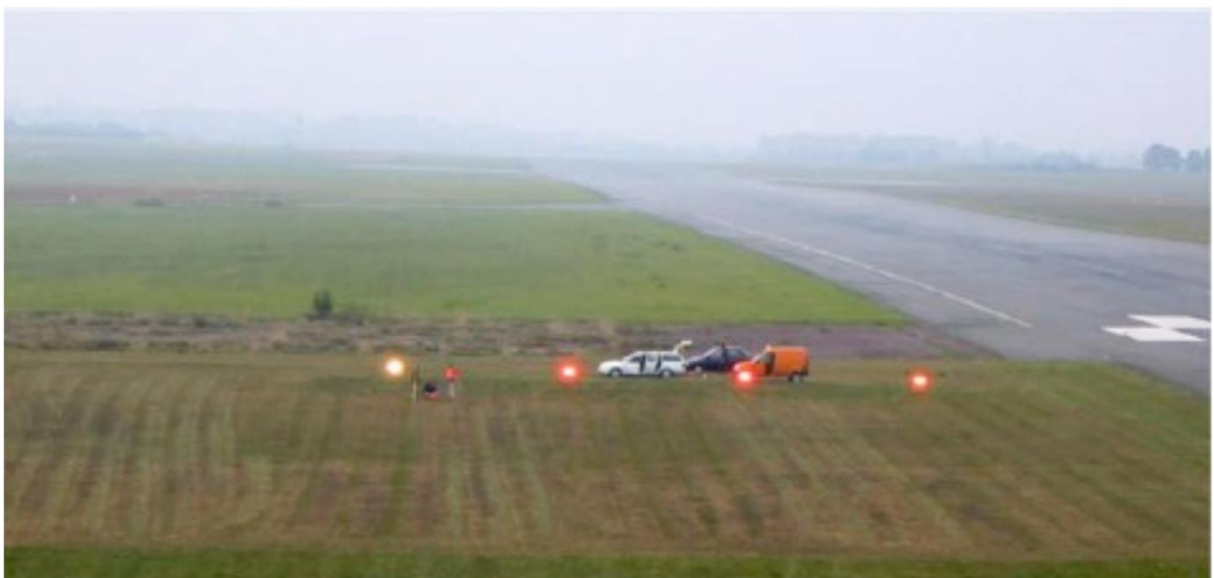
Hình 8-16. Hình ảnh đèn PAPI nhìn từ sà n nâng (Nguồn: STAC, Pháp)
