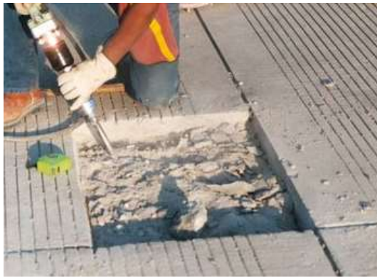
(a) Đục tẩy bê tông
