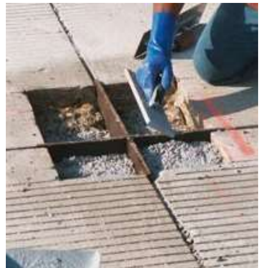
Hình 18 – Bố trí tấm chèn chịu nén tiếp giáp giữa miếng vá và cạnh tấm
