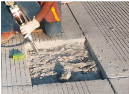
(a) Đục tẩy bê tông
