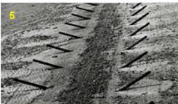
Ảnh 8 – Thi công sửa chữa vết nứt dọc theo phương pháp khoan đặt thanh liên kết xiên
