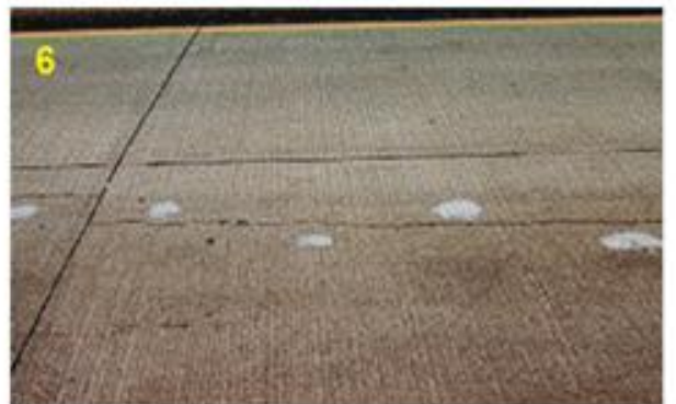
Ảnh 8 – Thi công sửa chữa vết nứt dọc theo phương pháp khoan đặt thanh liên kết xiên
