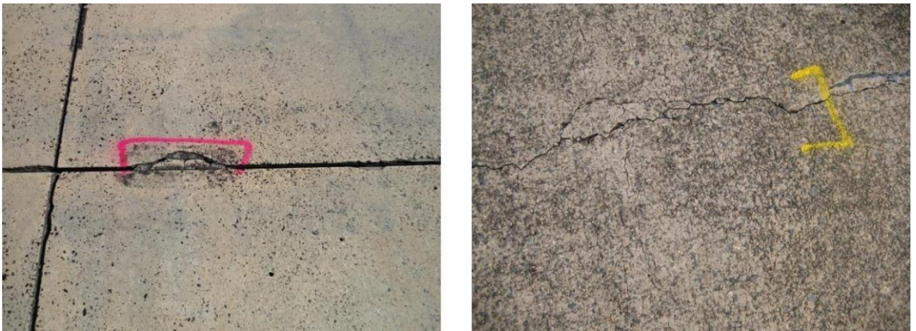
Hình 11 – Nứt mẻ nhỏ tại khe nối và vết nứt
