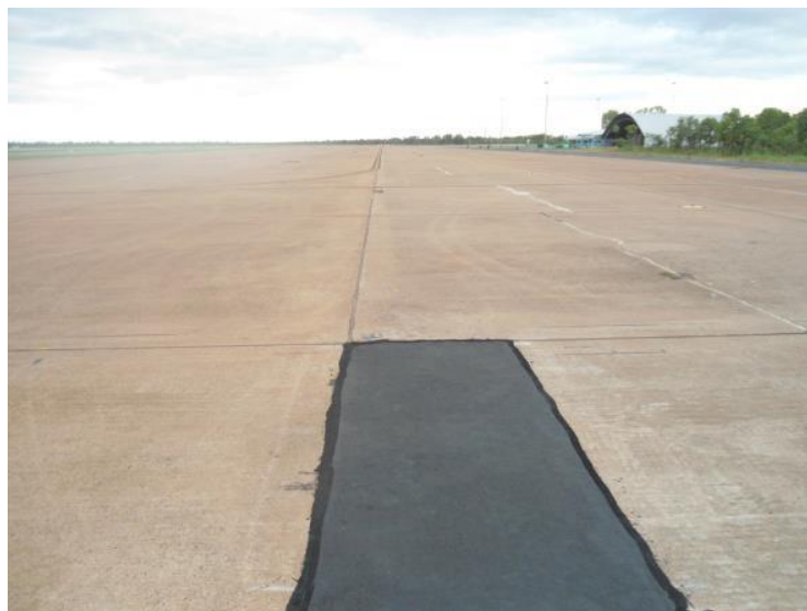
Ảnh 10 – Vị trí sứt vỡ được xử lý hoàn thiện bằng hỗn hợp đá nhựa
