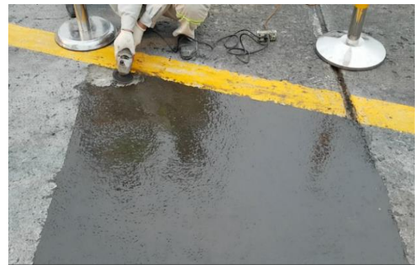
(b) Mài hoàn thiện bề mặt bê tông polime sau khi cứng
