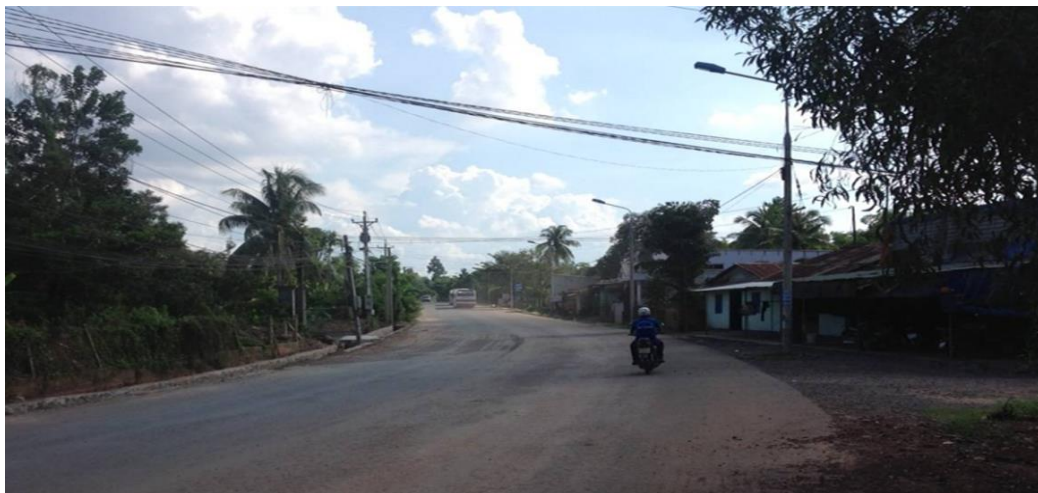
Hình 2-6 Hiện trạng hệ thống đường giao thông trong khu vực quy hoạch
