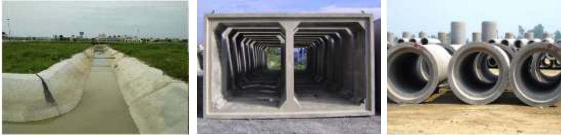
Hình 5.14: Định hình các tuyến thoát nước: Mương, cống hộp, cống tròn
