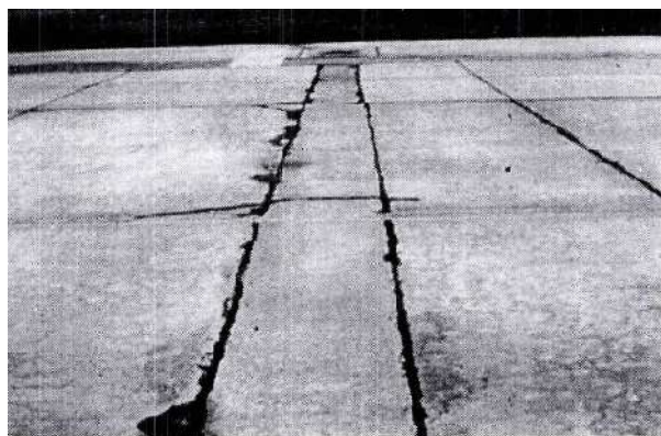
Hình B.35 – Chỗ cắt đặt công trình ngầm hồng nhẹ
