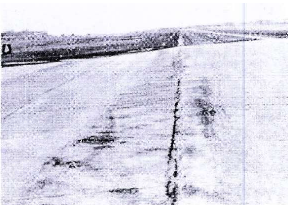
Hình A.71 – Xô đẩy hư hỏng nhẹ ở bên ngoài và hư hỏng trung bình ở giữa
