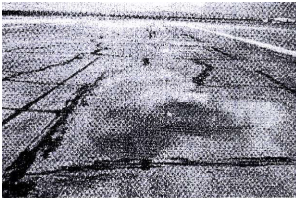
Hình – A.27 Vỡng mặt hư hỏng cao (50 mm)
