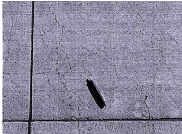
Hình B.75 – Phản ứng kiểm hồng trung bình
