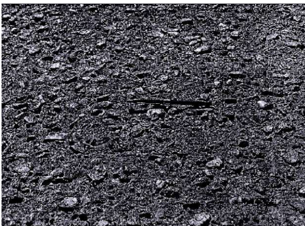
Hình A.81 – Lão hóa hư hỏng cao (Hao mòn bề mặt)
