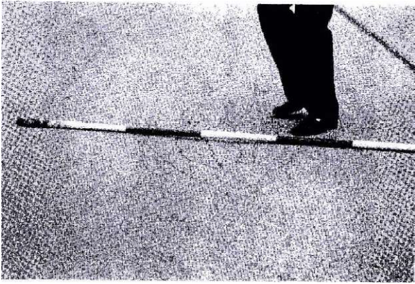
Hình A.4 – Nứt da cá sấu hư hỏng trung bình (chú ý đến vũng xảy ra cùng với nứt)
