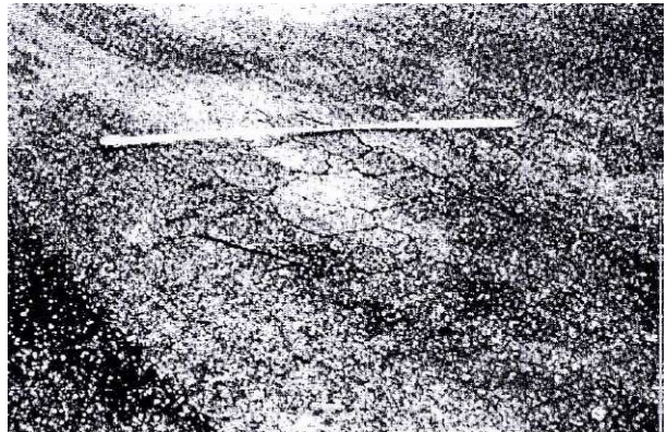
Hình A.7 – Nứt da cá sấu hư hỏng trung bình, tiếp cận đến hư hỏng cao
