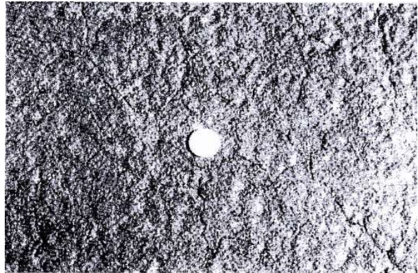
Hình A.15 – Nứt hình khối nhỏ, khe sợi tóc hư hỏng nhẹ
