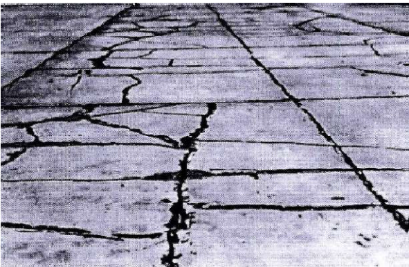
Hình B.57 – Tấm bị dập
