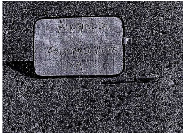
Hình A.80 – Lão hóa hư hỏng trung bình (Hao mòn bề mặt)
