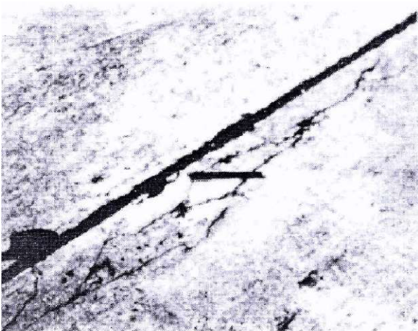
Hình B.20 – Nứt “D” hư hỏng trung bình
