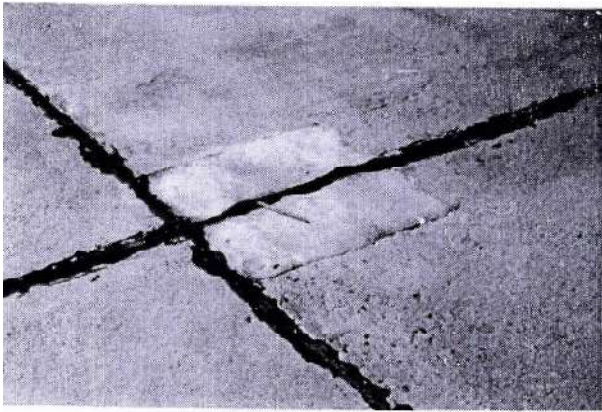
Hình B.28 – Miếng vá nhỏ hình chữ thập
