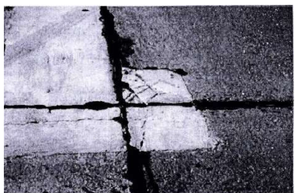
Hình B.31 – Miếng vá nhỏ hình chữ thập
