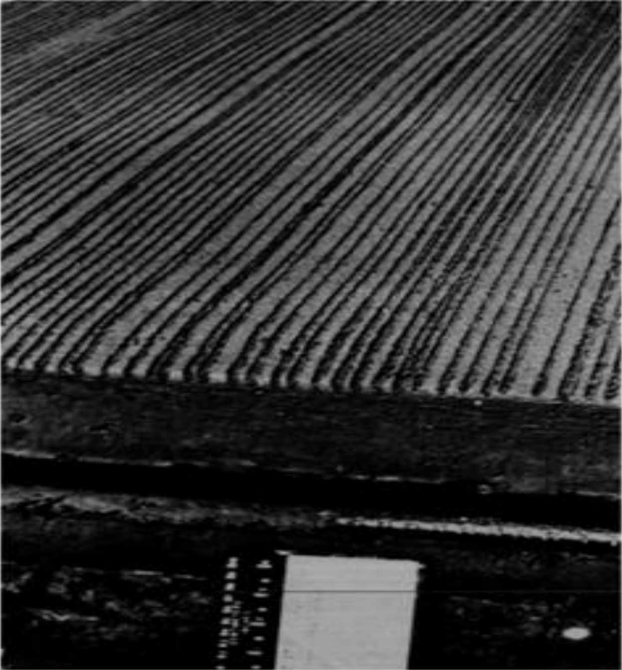
Hình 5 - Hình ảnh bề mặt mặt đường sau khi được tạo nhám bằng kết cấu kỹ thuật wire comb tại sân bay Patrick Henry, Virginia với cấu trúc sử dụng 1/8 inch x 1/8 inch x 1/2 inch (wire comb technique constructed at Patrick Henry Airport, Virginia, using a 1/8 inch x 1/8 inch x 1/2 inch configuration)
